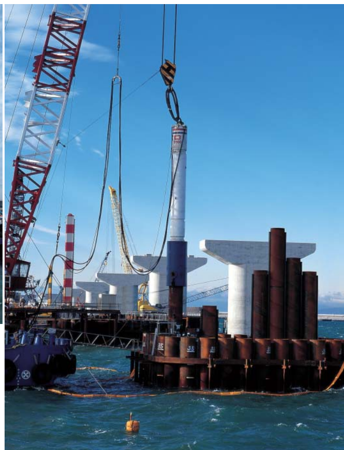
施主：日本鉄道建設公団名古屋建設局 工事名：中空連鉄、空港連絡B(東)他
