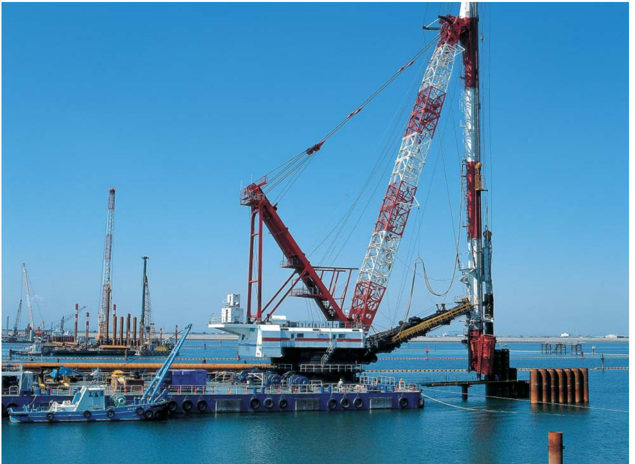
施主：日本道路公団名古屋建設局四日市工事事務所 工事名：第二名神高速道路木曾川橋(下部工)工事
