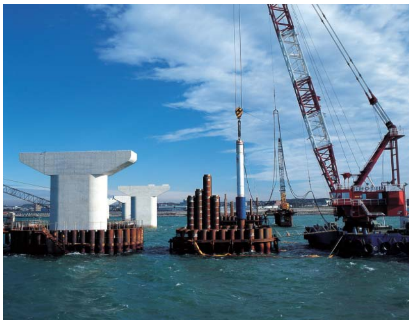
施主：愛知県企業庁 工事名：空港島道路連絡橋下部築造工事 TKH12-5
